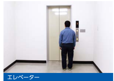
エレベーター
