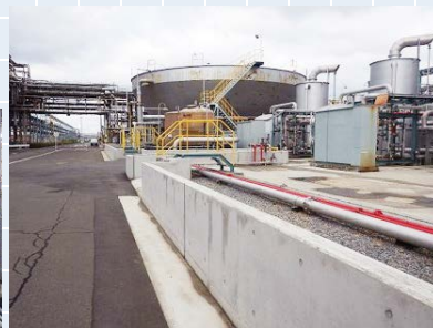
コンクリート製防潮堤
