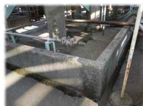
【川崎工場 防液提の様子】
