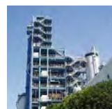
使用済みプラスチックをガス化し、水素やアンモニア、炭酸ガス、ドライアイスなどの材料として再生することで循環型社会の構築に貢献
