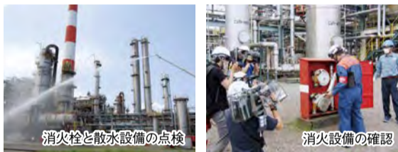
消火栓と散水設備の点検
