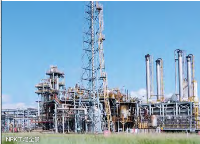
NRK工場全景
