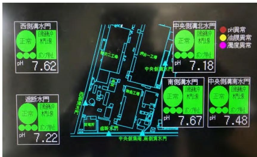
写真2. 排水監視モニター
