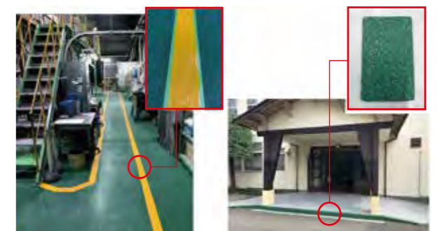
塩尻工場 転倒災害対策(滑り止め塗装)
