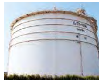
浮き屋根式ナフサタンク
