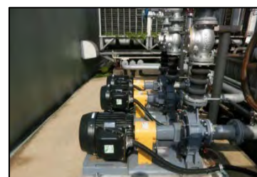
高効率モーターの冷却水ポンプ
