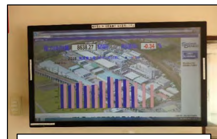
電力監視システムモニター
