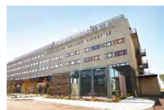
川崎臨海部ホテルの純水素型燃料電池
