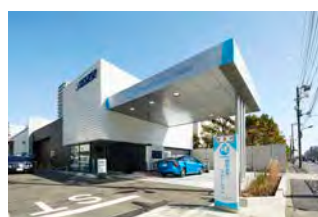
水素ステーション
