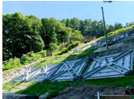
【グラウンドアンカー工法 受圧板】
