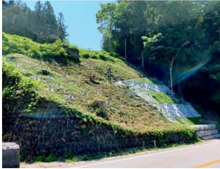
【水槽法面補強工事完了】
