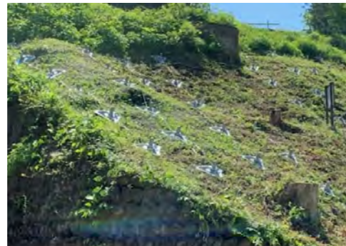
【ノンフレーム工法】
