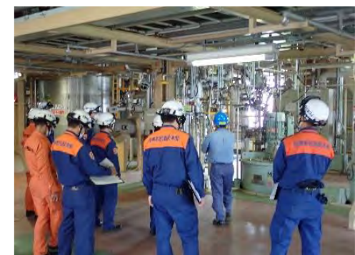
消防による現場調査の様子
