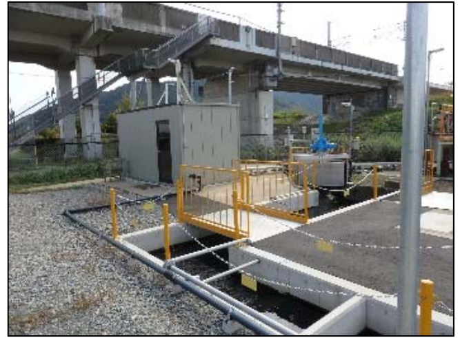
環境監視機器用の小屋
