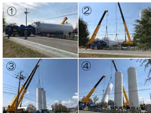
タンク設置工事の様子
