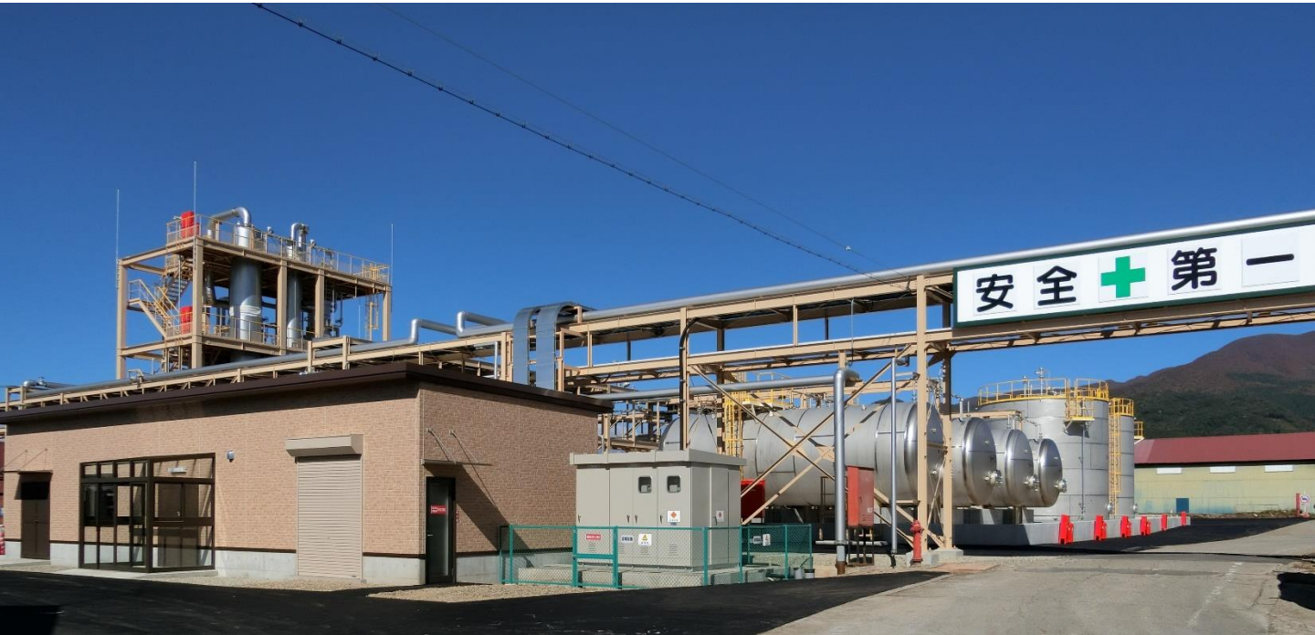
高純度溶剤製造新プラント
