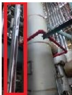
【2018年 大分工場 LYBの設計基準により、高圧ガス機器のレベル計の変更】
