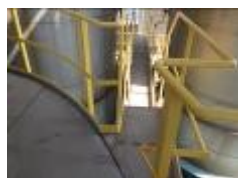
【2018年 大分工場 腐食対策の為、カーボンスチール製の床の材質をステンレススチール製に変更】
