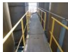
【2018年 大分工場 腐食対策の為、カーボンスチール製の床の材質をステンレススチール製に変更】
