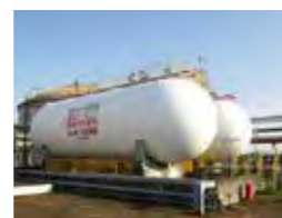
防護フェンス
