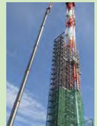
フレアースタック耐震補強工事
