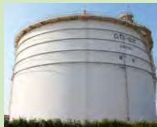
浮き屋根式ナフサタンク
