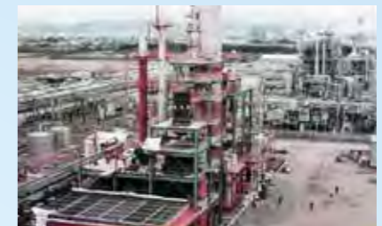
建設途中の酢酸ビニルプラント
