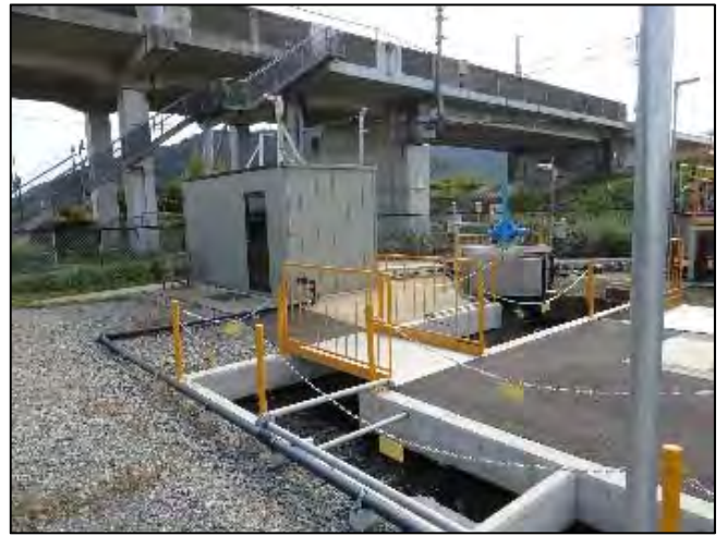
環境監視機器用の小屋
