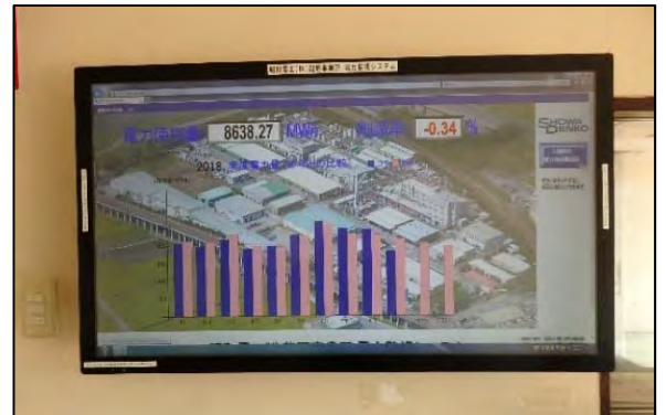
電力監視システムモニター
