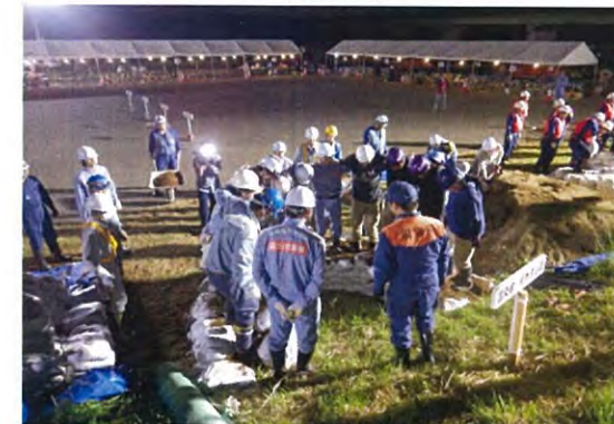
月の輪工法実施状況②
