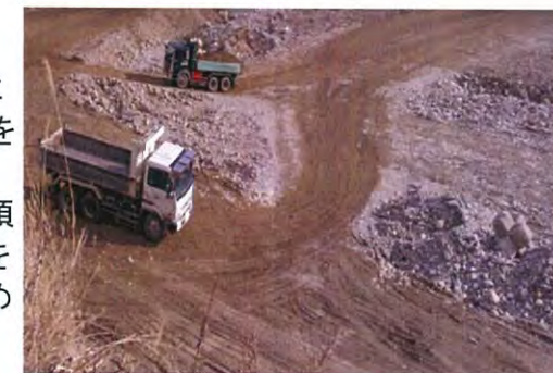
土砂運搬状況
