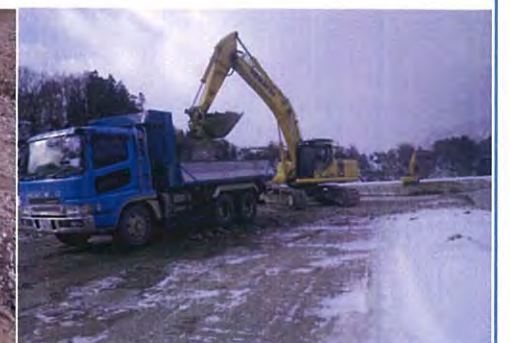
掘削・積込状況
