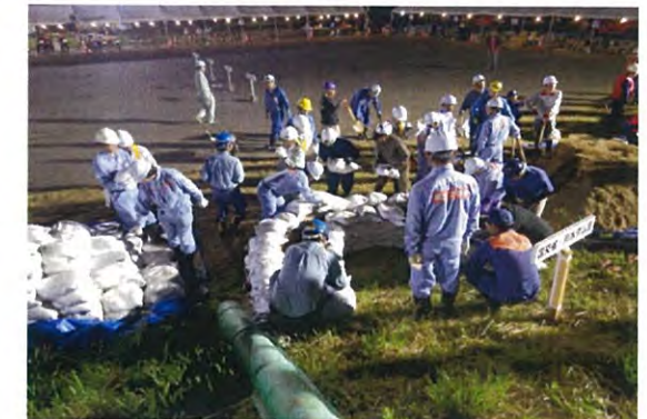
月の輪工法実施状況①
