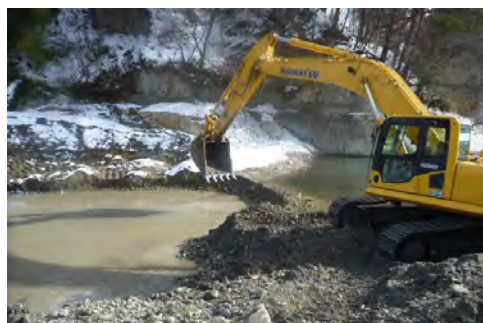
掘削工事の様子
