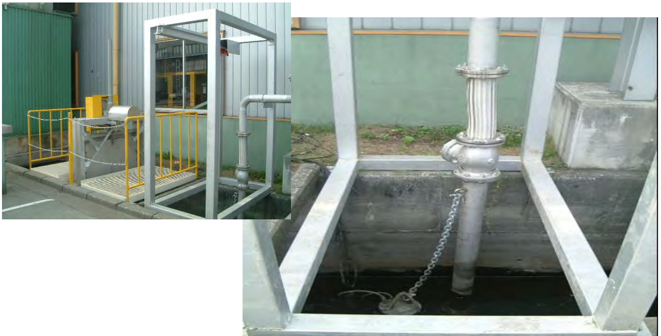
写真1. 緊急時用水門
