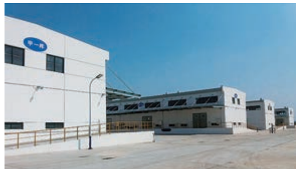
上海昭和化学品有限公司武漢分公司が入居する倉庫
