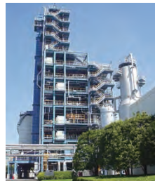
プラスチック・ケミカルリサイクルプラント
