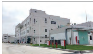
昭和電工新材料（珠海）有限公司
