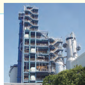
プラスチック・ケミカルリサイクルプラント
